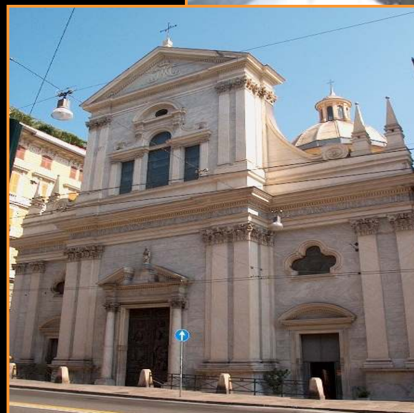
Area accessibile e con segnalazione all'interno della Chiesa N.S. della Consolazione
